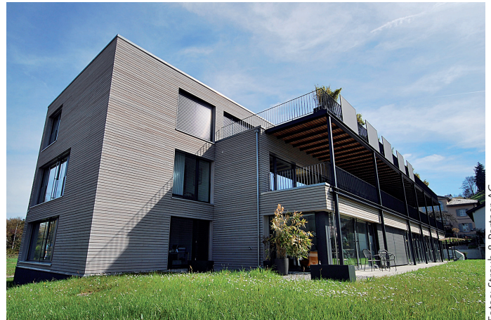
Der neue Geschäftssitz an der Niederlenzerstrasse 10 in Lenzburg.
