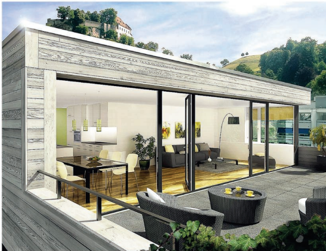
Grossflächige Fensterfronten schaffen ein aussergewöhnliches Raumgefühl.
