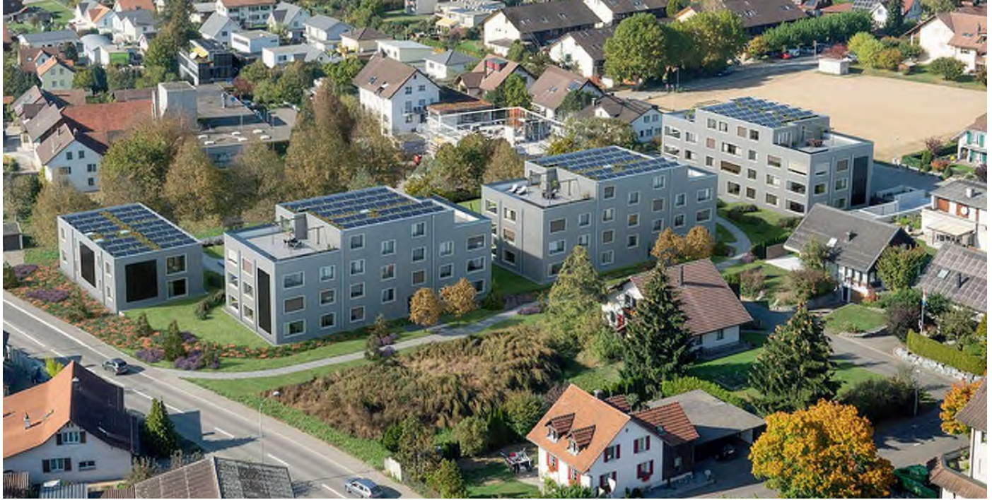
Bild 1: Areal-Überbauung in Möriken-Wildegg AG nach Minergie-P-Eco®-Standard mit PV-Anlagen auf Dächern, Fassaden, und Terrassen-Brüstungen. (Bild: Setz Architektur AG)
