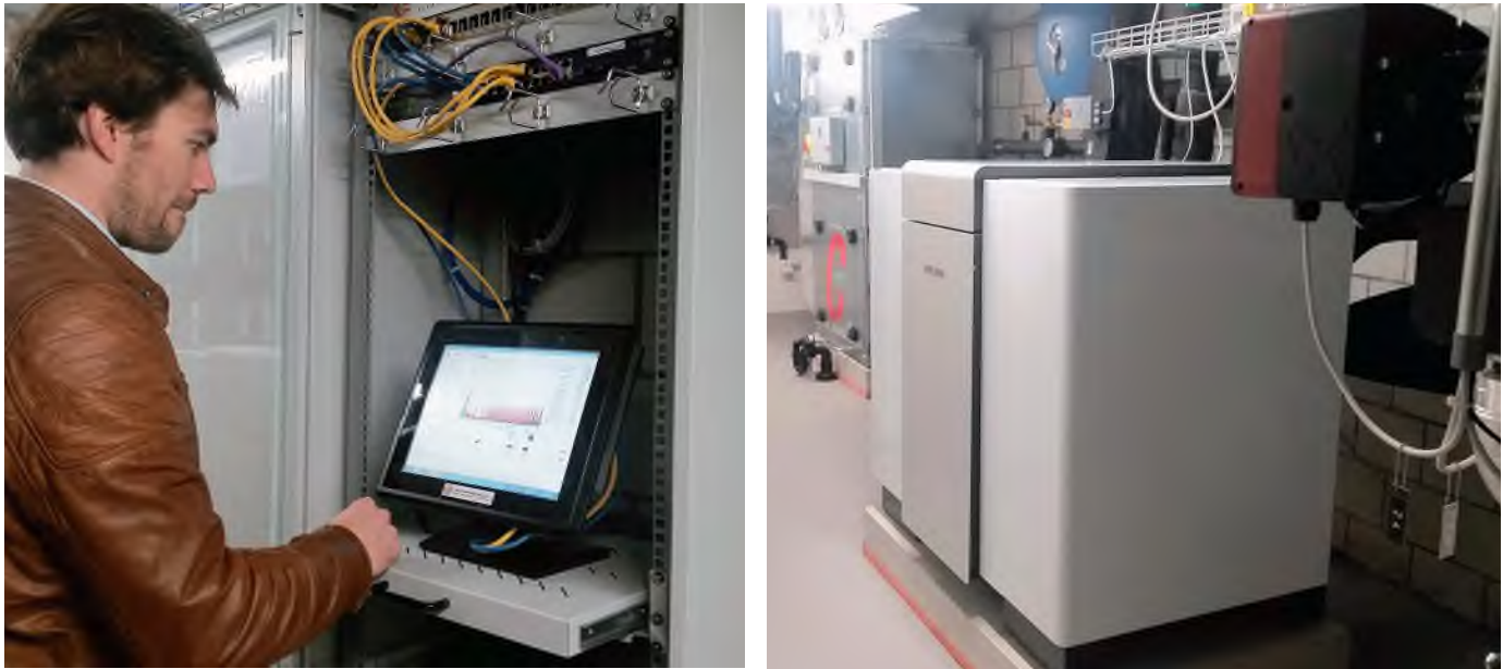
Bild 4: Eigenverbrauchsmanager von Smart Energy Control (links) und Wärmepumpe von Stiebel Eltron (rechts) mit Erdwärmesonden und «Natural Cooling». (Bilder: Smart Energy Control AG)
