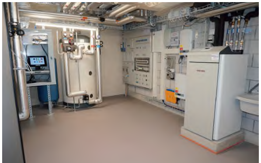
Bild 6: Technikraum in einem der vier MFH mit Eigenverbrauchsmanager-Bedienstelle, Speicher, Elektro-Hauptverteilung mit elf geeichten Stromzählern, Wechselrichter und weiteren Elektroinstallationen zu PV-Anlagen, Wärmepumpe. (Bild: Smart Energy Control)
