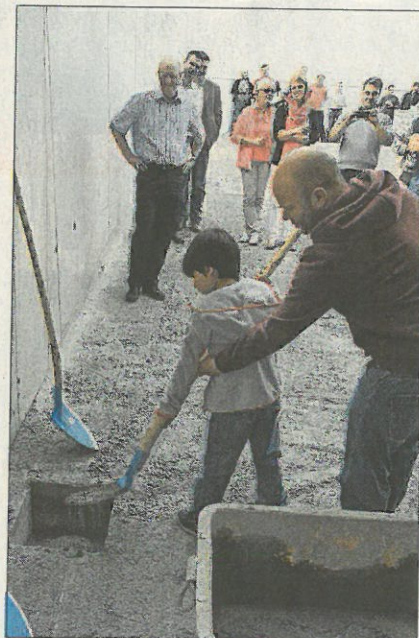
Der Grundstein für das künftige Zuhause: Raoul legt an der Grundsteinlegung mit Vater Eduardo Perez Hand an.
